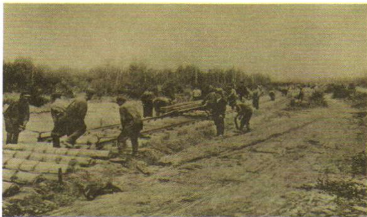
Рабочие на строительстве Сибирской железной дороги
